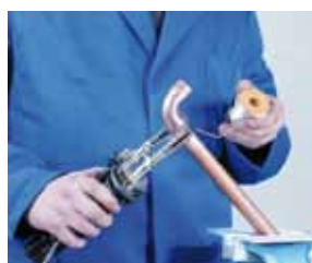
5. Aplicación de la soldadura 5. Aplicação da soldadura
