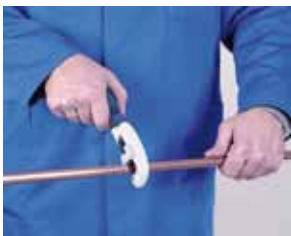
1. Corte de tubo 1. Cortar o tubo
